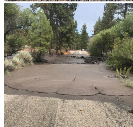
Esta imagen es de flujo de lodo y escombros despues de incendio Cranston en 8/17/18.
